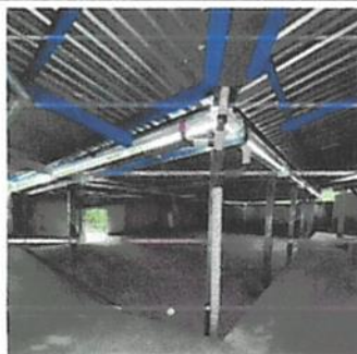
Foto 5: colocaron canaels para recoger las caidad de agua, alrededor de todo el techo colocado sobre el patio de recreo del centro educativo.
