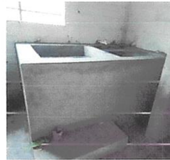
Foto 4: pila terminada, con la finalidad de guardar agua en la cocina, para lavar los trastos y la fruta y verdura y lo necesario para la elaboración de la refacción escolar para lo niños.
