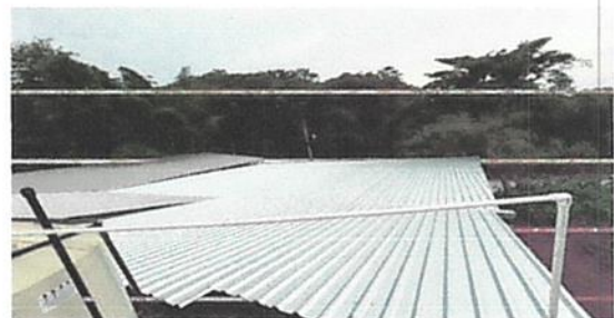
Foto 6: techo completo sobre el patio de recreo del centro educativo.
