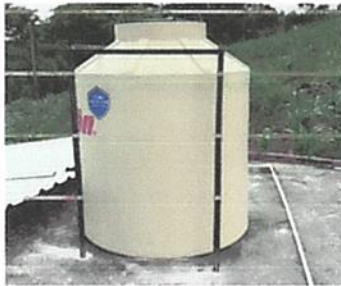
Foto 3: sustitución del depósito de agua que había por éste de mayor cantidad de espacio para guardar litros de agua, así como la armadura adecuada anti robo, para evitar pérdida del mismo.
